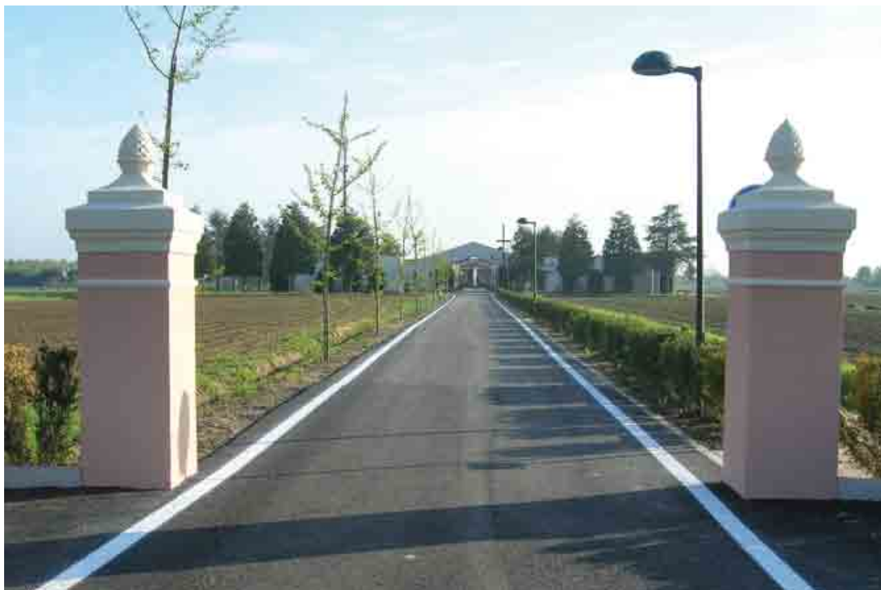
L'inizio del tratto riqualificato di via Cimitero
